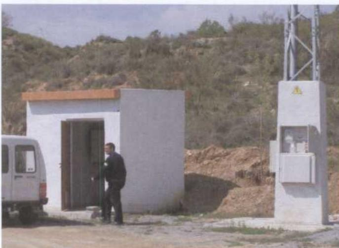
Tiene un caudal de 9 l/s. El nivel estático se sitúa a unos 70 m de la boca del sondeo y vierte directamente al depósito D-1, situado a 836 msnm de cota. Utiliza una electrobomba sumergible de 40 C.V, situada la aspiración a 140 m de profundidad. La tubería de transporte es de 5' en PVC. La impulsión puede funcionar manual y automáticamente mediante sondas de arranque electrónico y limitación horaria
